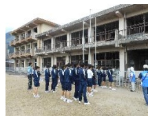
旧大野木場小学校 被災校舎
